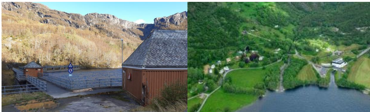
T.v. Demning og lukehus, Hålandsvatnet. Bygd ca. 1920. Lukehusa til regulering av vasstand og flaumvatn er forseggjorte med valma skifertak og fint detaljerte dører. T.h Litledalsgrenda og kraftstasjonen. Foto: Espen Mills (2009)
