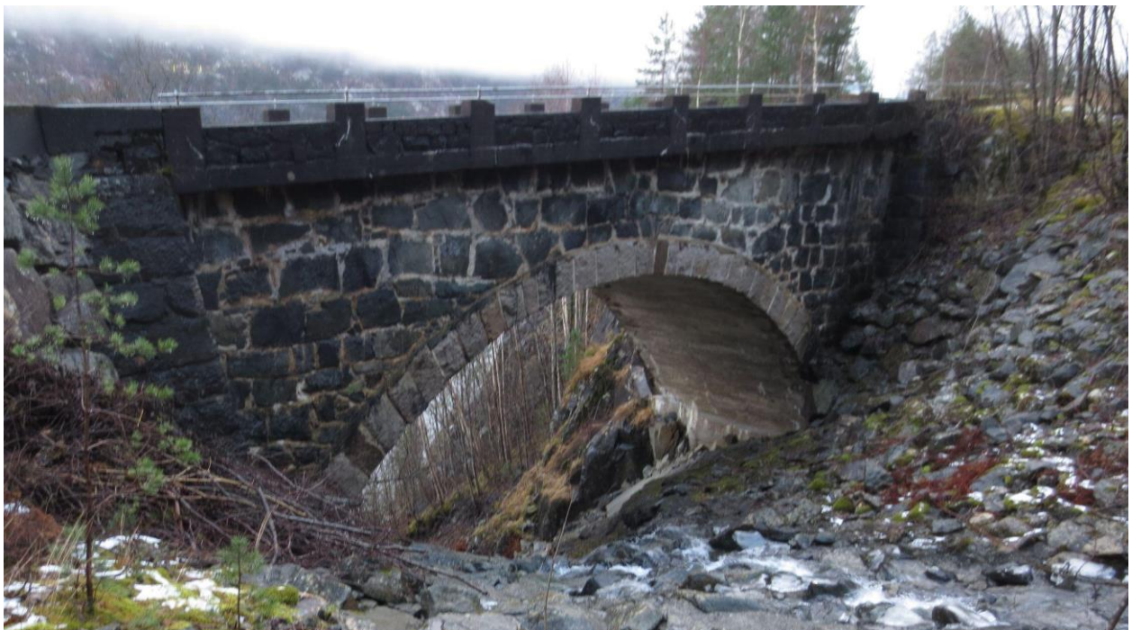
Skålnes bru ved Markhus.
