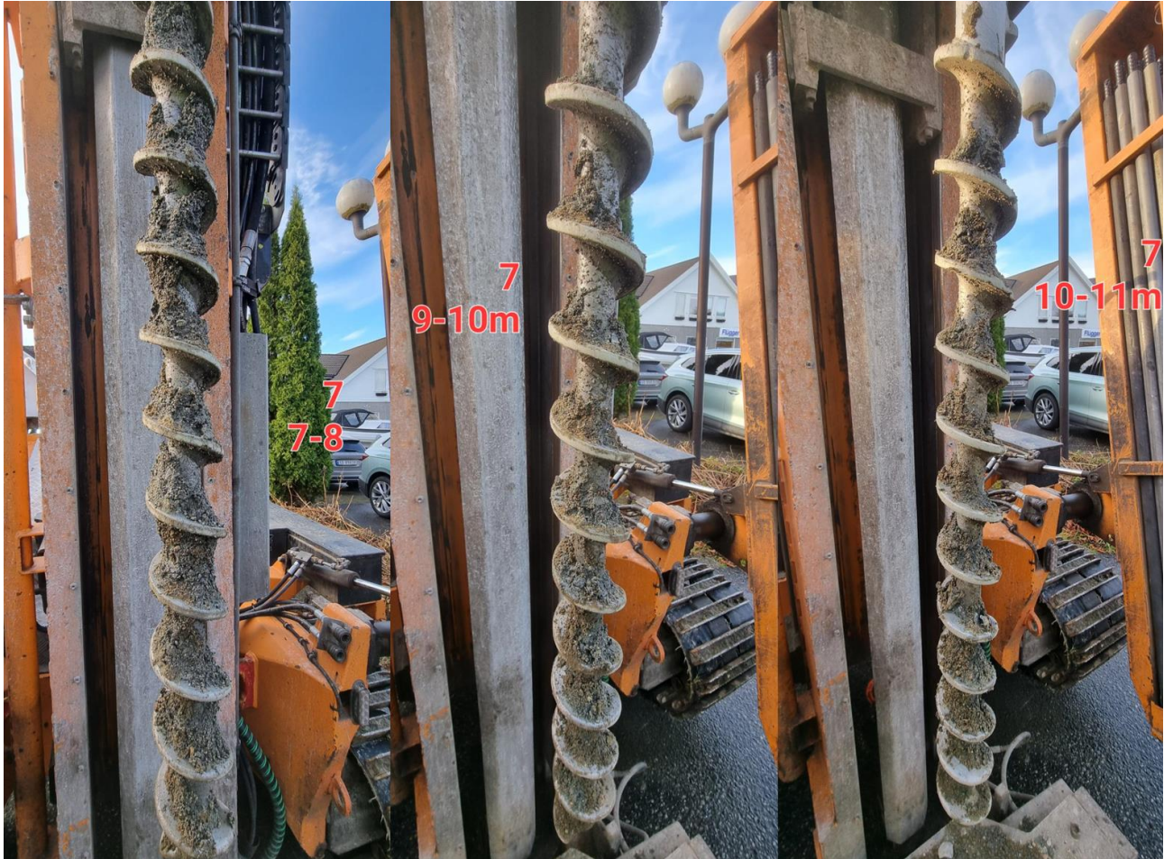
Figur 6: Bildene viser bilder av opptatt prøver i borpunkt 07 under de geotekniske grunnundersøkelsene.
