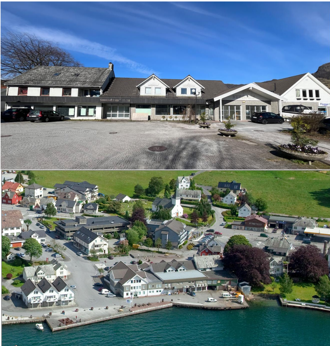
Figur 48 Øvst: Bilde av bygningsmasse som er vendt mot dagens torg. Nedst: Skråfoto frå 2009.
