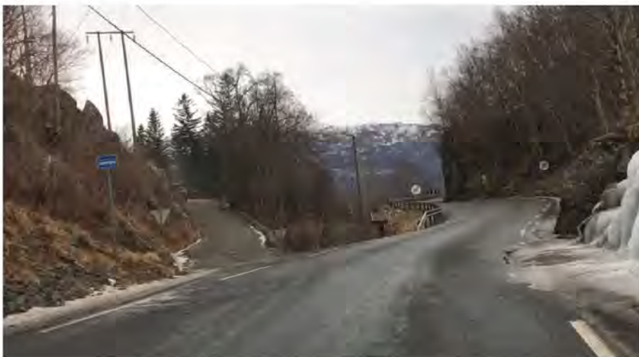
Figur 5-4: Skilta kantstopp for buss langs strekningen Skånevik Flesjo. Ein ser også danning av is langs vegen. Foto Multiconsult Norge ASA
