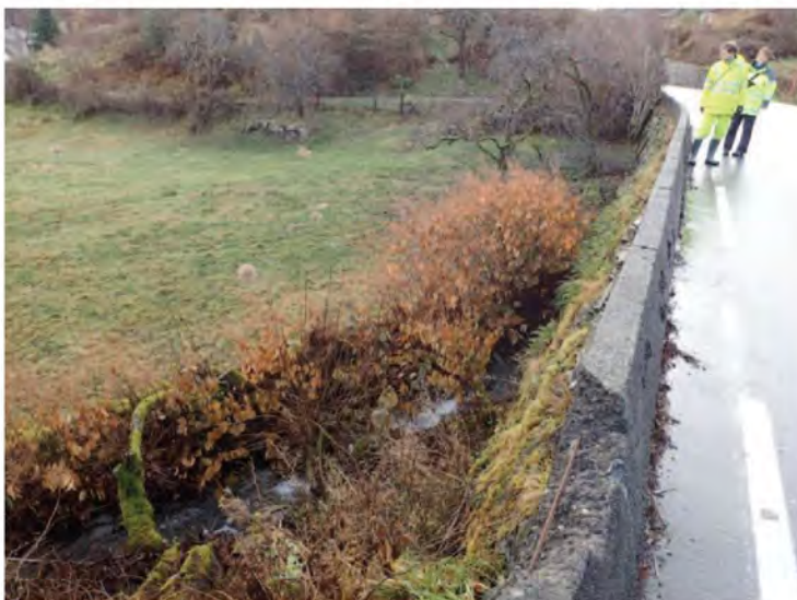
Figur 5-17: Parkslirekne langs bekk på nedsida av dagens veg. Foto: Multiconsult Norge ASA.
