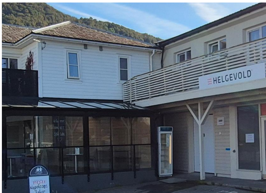
Figur 3-4: Innvendig hjørne med tilsynelatende uklassifiserte vinduer
